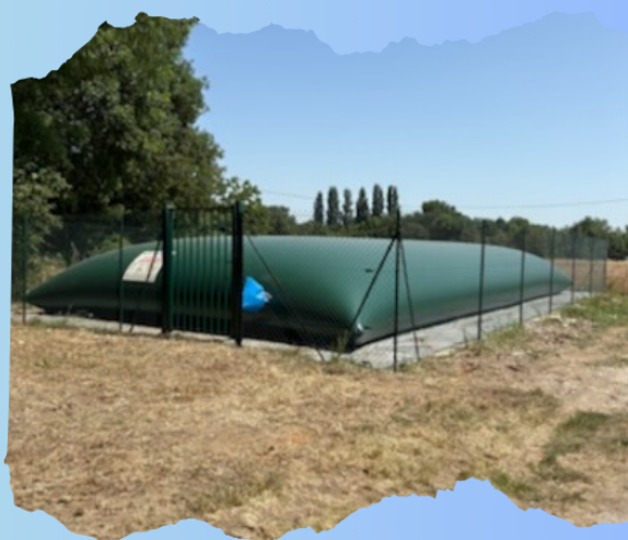
MISE EN PLACE DES CITERNES INCENDIES
