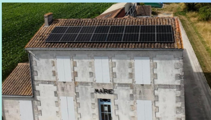
MISE EN PLACE DE PANNEAUX SOLAIRE SUR LA MAIRIE
