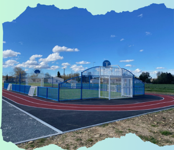
MISE EN PLACE DU CITY PARK
